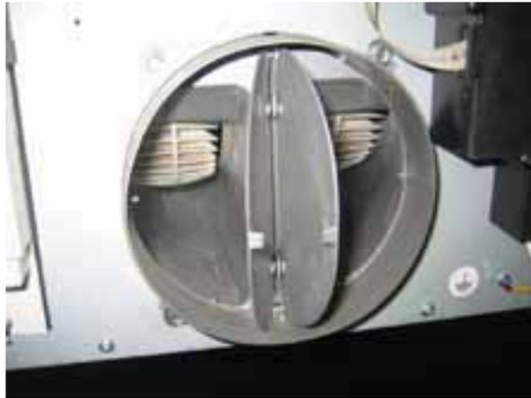
No caso de uma instalação na versão aspirante, a aplicação das válvulas de NÃO-retorno impede a entrada do vento e o retorno de ar.
