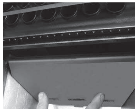
Fig. 14: levantar a placa corta-fogo
