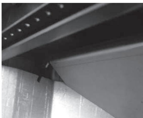
Fig. 15: levantar a placa corta-fogo
