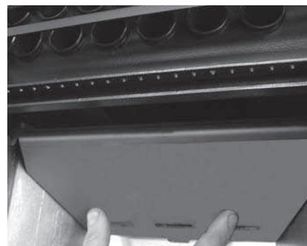
Fig. 14: levantar a placa corta-fogo
