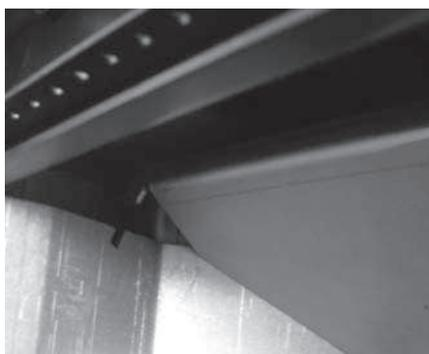
Fig. 15: levantar a placa corta-fogo
