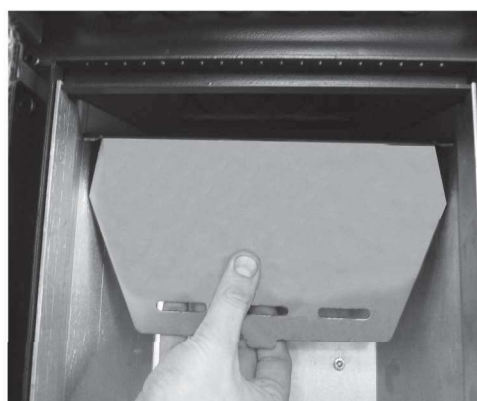
Fig. 13 Virar a placa corta-fogo
