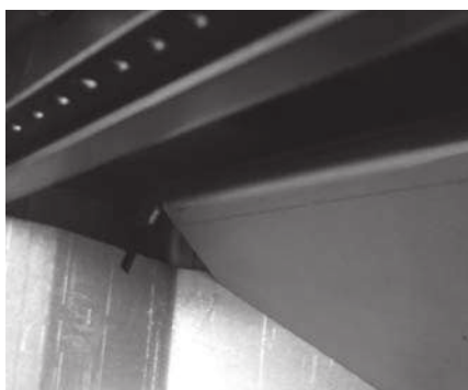
Fig. 15: levantar a placa corta-fogo
