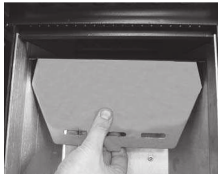
Fig. 16: rotação da placa corta-fogo
