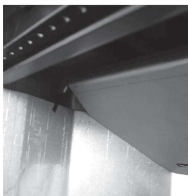
Fig. 12 Levantar a placa corta-fogo
