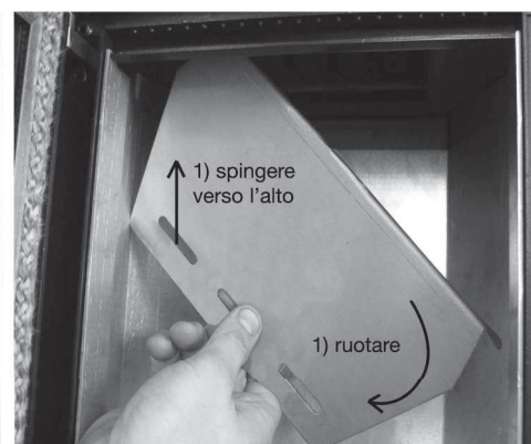
Fig. 14 Retirar a placa corta-fogo
