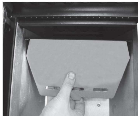
Imagen 13: Gire la placa de protección de fuego
