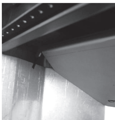
Fig. 12 Levantar a placa corta-fogo
