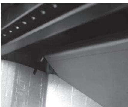
Fig. 15: levantar a placa corta-fogo
