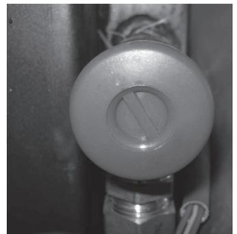
**Válvula de segurança:** esta válvula actua para evitar o excesso de pressão do sistema hidráulico. Se a pressão do sistema de caldeira ou excede 2,5 bar drena a água do circuito.
