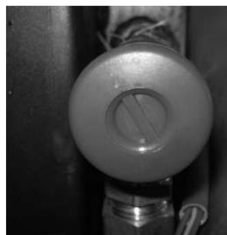
**Válvula de segurança:** esta válvula actua para evitar o excesso de pressão do sistema hidráulico. Se a pressão do sistema de salamandra hidro ou excede 2,5 bar drena a água do circuito.
