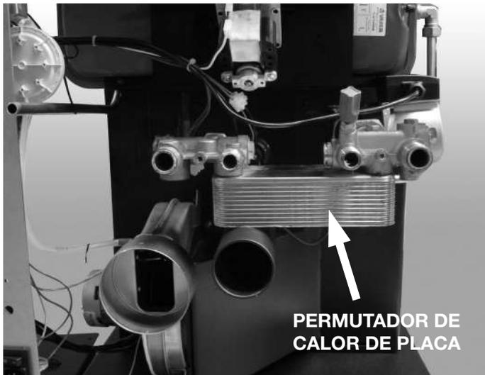
O kit é pré-montado pelo fabricante tem a tarefa de aquecer a água doméstica a partir da linha de água da habitação. No momento em que há uma demanda de água quente, abrindo uma torneira, a chave de fluxo comanda a válvula de desvio para transportar a água quente contida dentro do aquecedor para o trocador de calor.
